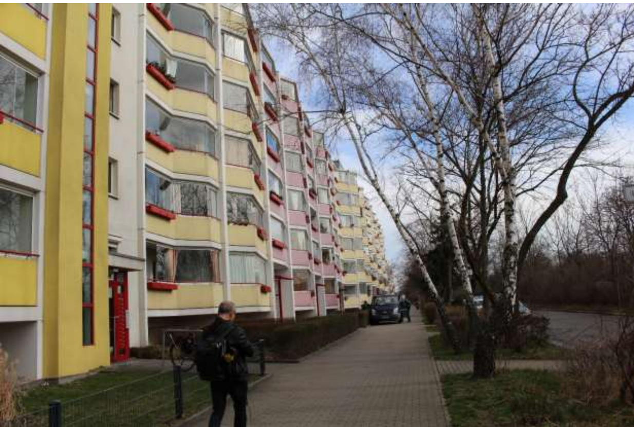
第二次大戦後建設された集合住宅団地 アパートの修復/改善
